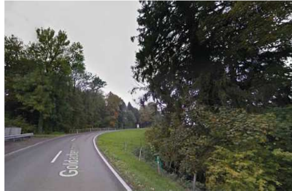
Standort des Durchlasses Hochstudenbach
