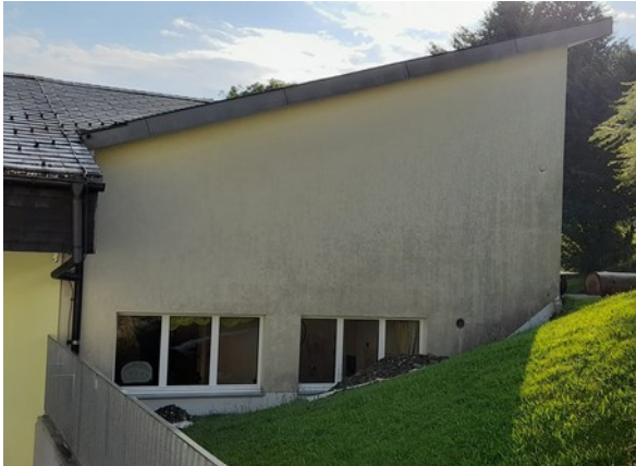
Westfassade Kindergarten Im Hof
