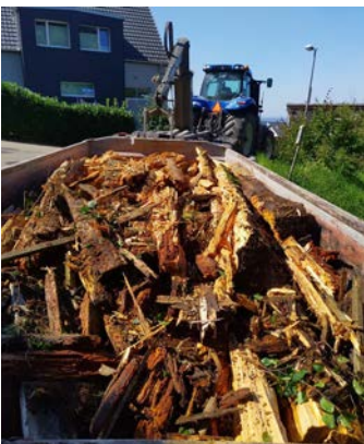
Morsches Holz der alten Brücke
