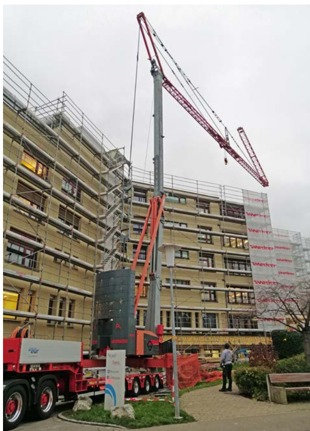
Pflegeheim «PeLago» im Umbau
